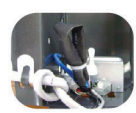
SHRINK TUBE หลอดกั้นข้อสายไฟ ใช้วัสดุไม่ลุกไหม้ไฟ ป้องกันการเกิดไฟฟ้ลัดวงจร ที่ก่อให้เกิดประกายไฟ
